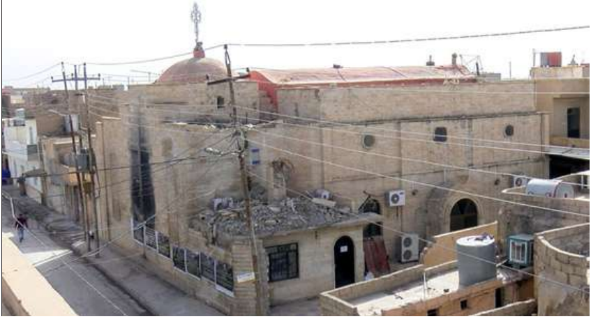
لوح (٥٤) منظر عام لكنيسة مريم العذراء في برطلة وتظهر آثار تدمير برج الكنيسة وصليب الواجهة الأمامية
