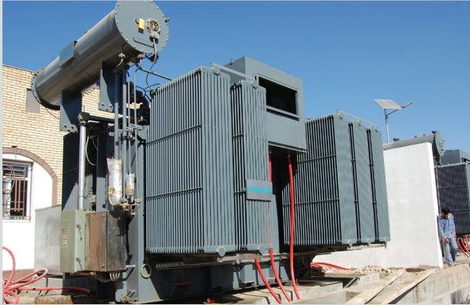
شرعت الأمانة العامة للعتبة الحسينية المقدسة ببناء محطة الحرمين الكهربائية الأولى التي تقوم بتحويل ثانوي للتيار الكهربائي ومن شأنها المساهمة في استقرار الطاقة المجهزة لها ، و فك الاختناقات الحاصلة في شبكة الضغط المتوسط في المدينة القديمة.
